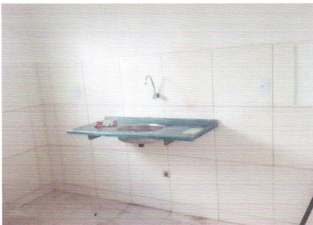
FOTO 06 – PIA DE COZINHA COM BANCADA EM AÇO INOX
