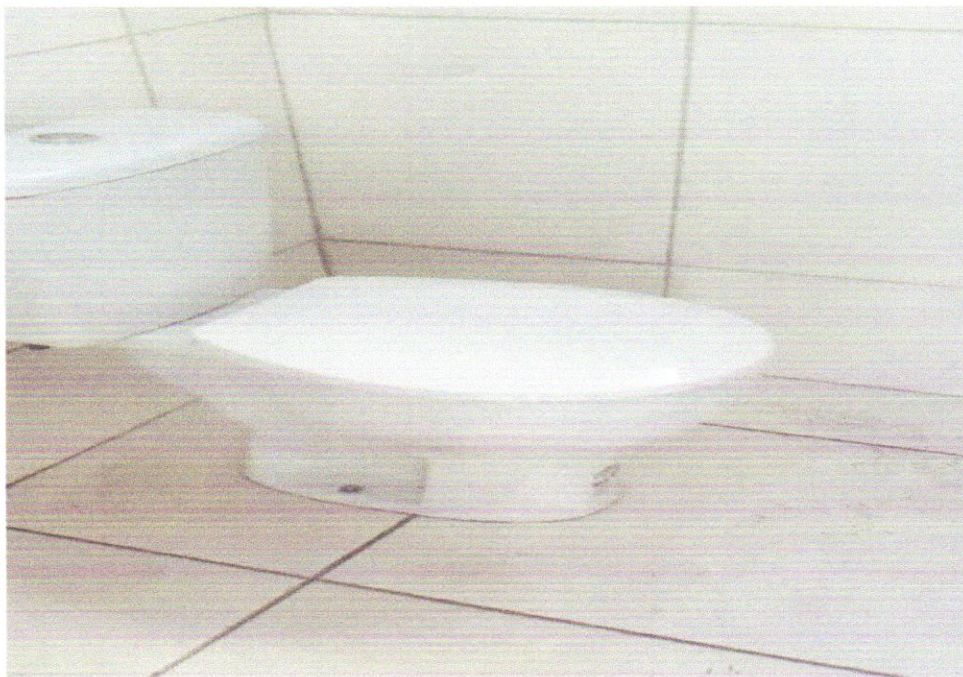
FOTO 03- VASO SANITARIO SIFONADO CONVENCIONAL COM LOUÇA BRANCA - FORNECIMENTO E INSTALAÇÃO
